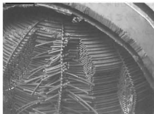
図3 切断中の細管束の状況
