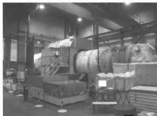
図2 処理セルでの蒸気発生器の切断
